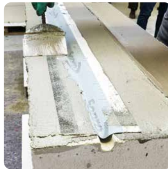
Einlegen des Dichtbandes
