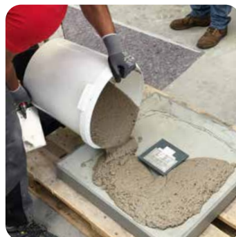
Verguss von Einbauteilen
