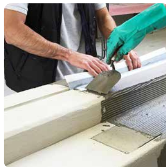
Abdichten des Beckenkopfes
