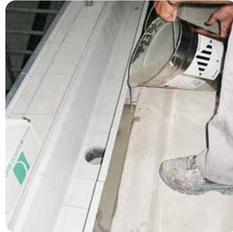
Verguss der kapillarbrechenden Fuge
