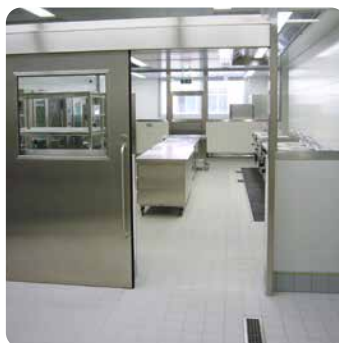
Großküche mit Bodenabläufen
