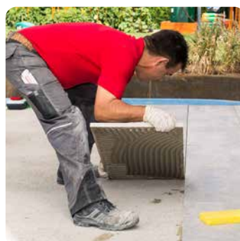
Verlegung von Platten auf Drainagemörtelschicht
