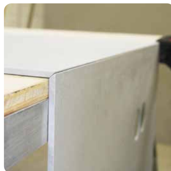
Großformatfliese auf Gehrung geschnitten
