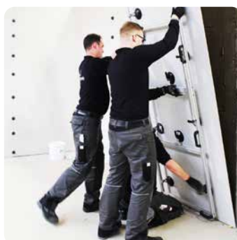
Verlegung der Platten mit Spezialwerkzeugen
