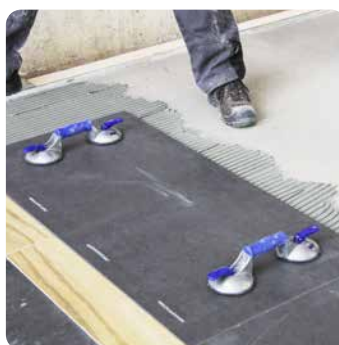
Verlegung der Platten mit Spezialwerkzeugen
