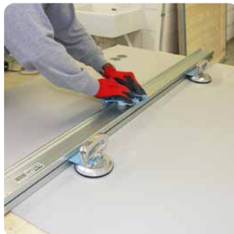
Schneiden von großformatigen Platten
