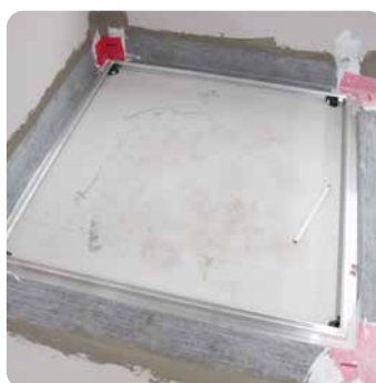
Eingedichtete Dichtbänder im Bereich der Duschecke
