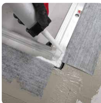
Eindichten der WannenDichtBand-Komponenten
