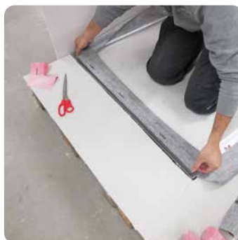
Anbringen der Dichtbänder
