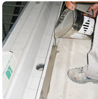
Verguss der kapillarbrechenden Fuge
