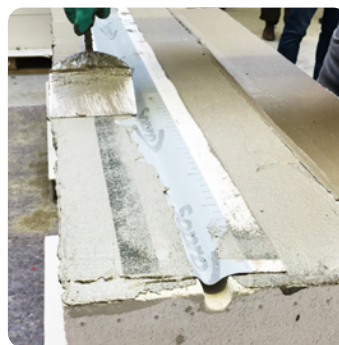
Einlegen des Dichtbandes
