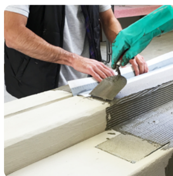
Abdichten des Beckenkopfes
