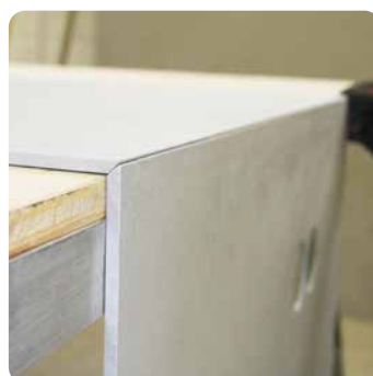
Großformatfliese auf Gehrung geschnitten
