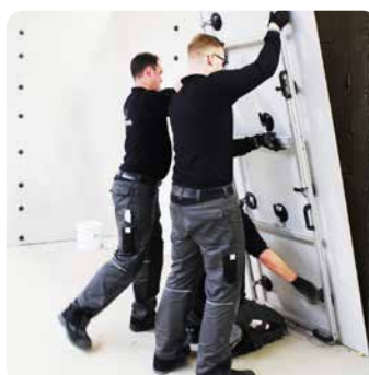
Verlegung der Platten mit Spezialwerkzeugen
