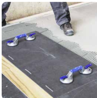
Verlegung der Platten mit Spezialwerkzeugen
