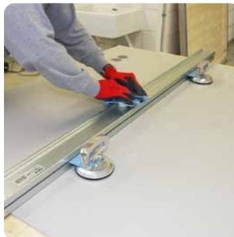
Schneiden von großformatigen Platten
