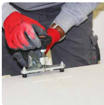
Anbringung einer Brechvorrichtung an einer Großformatfliese
