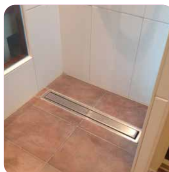
Duschrinne in bodengleicher Dusche
