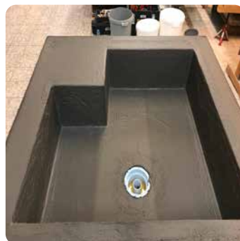
Fertig abgedichtetes Prüfbecke
