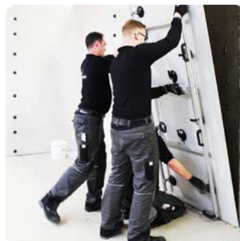
Verlegung der Platten mit Spezialwerkzeugen
