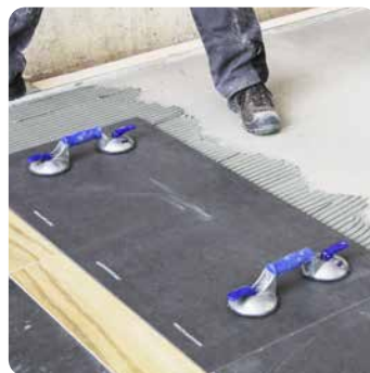
Verlegung der Platten mit Spezialwerkzeugen
