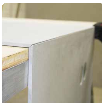
Großformatfliese auf Gehrung geschnitten
