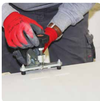
Anbringung der Brechvorrichtung an einer Großformatfliese
