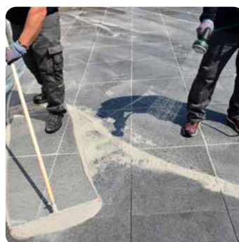
Verfugen mit Sopro Solitärfuge
