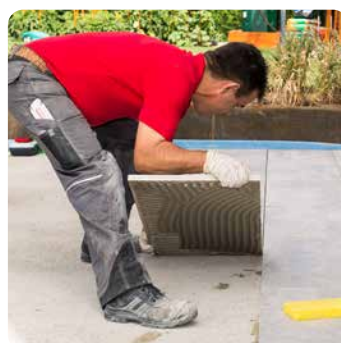
Verlegung von Platten auf Drainagemörtelschicht
