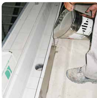
Verguss der kapillarbrechenden Fuge
