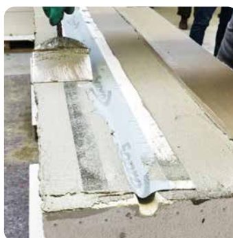
Einlegen des Dichtbandes
