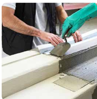
Abdichten des Beckenkopfes
