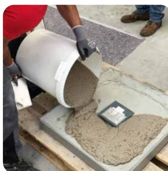
Verguss von Einbauteilen
