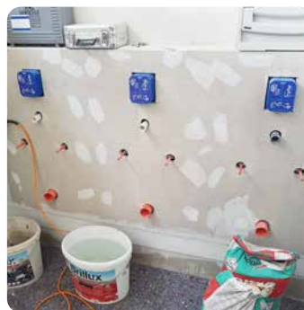
Vorbereitung der Trockenbauunterkonstruktion
