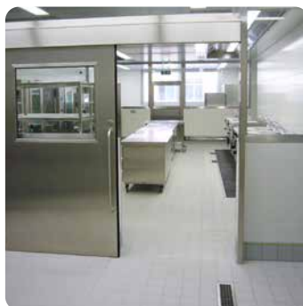
Großküche mit Bodenabläufen
