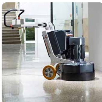
Oberflächenbearbeitung (Schleifen) eines Estrichs
