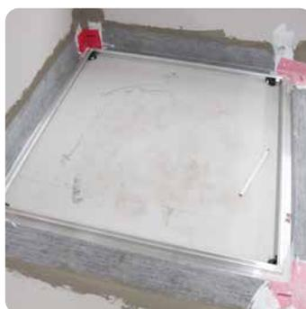
Eingedichtete Dichtbänder im Bereich der Duschecke
