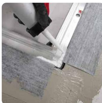
Eindichten der WannenDichtBand-Komponenten
