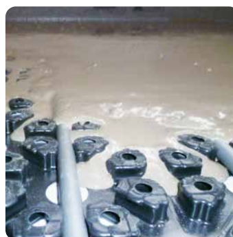
Fließspachtel umschließt das Heizsystem
