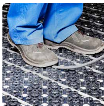
Verlegen der Heizschlangen
