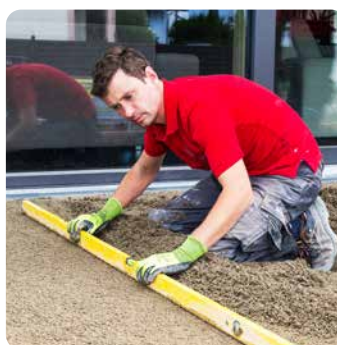
Einbau des Drainagemörtels
