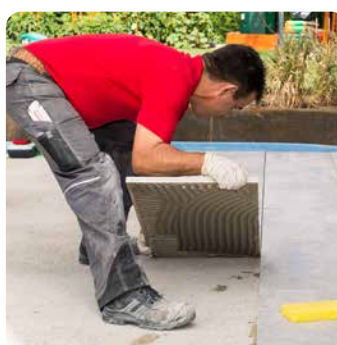
Verlegung von Platten auf Drainagemörtelschicht
