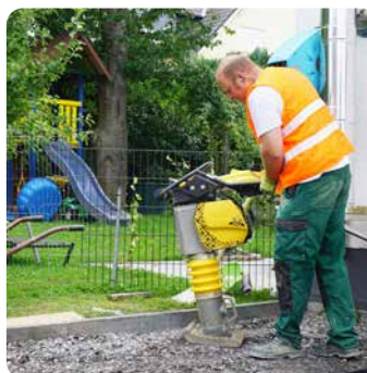
Richtige Unterbauvorbereitung als Basis von langlebigen Pflasterflächen
