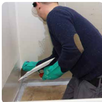
Verarbeitung Reaktionsharzabdichtungen
