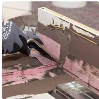
Verarbeitung Bahnenabdichtungen
